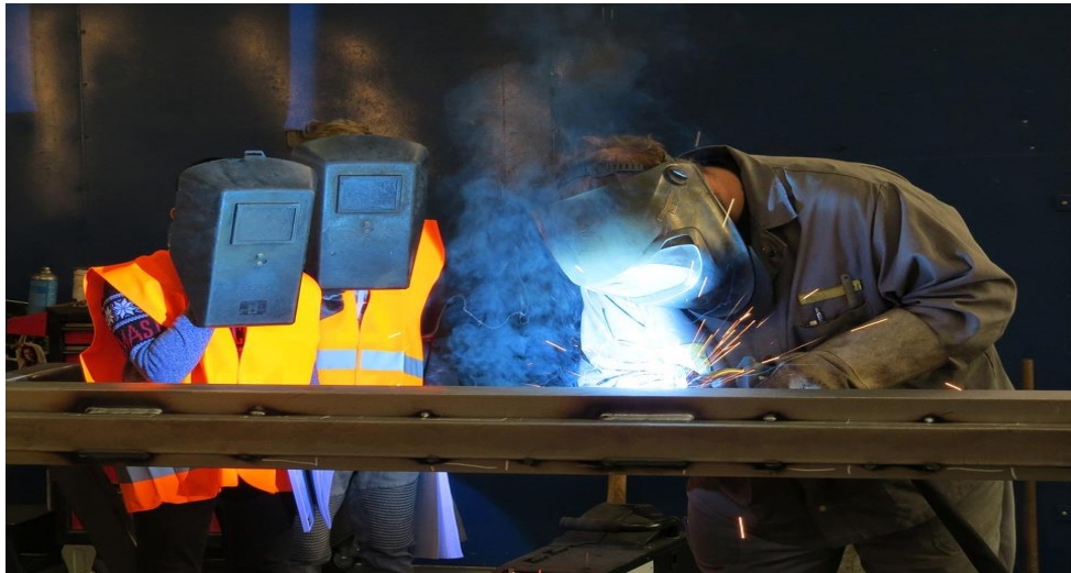
Gambar 4.2 Pembelajaran Pengelasan Dilapangan
